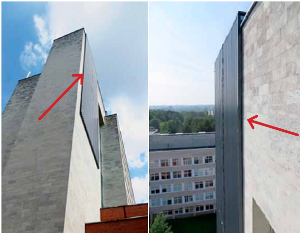
1 pav. VGTU neįstiklintas pratakus saulės kolektorius Fig. 1. An unglazed transpired solar collector arranged at Vilnius Gediminas Technical University
